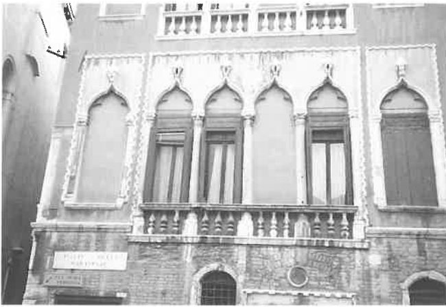
Πρόσοψη δίπλα στη γέφυρα των θαυμάτων
